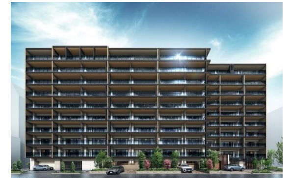
クリオレジダンス川口幸町 (2024年竣工)
